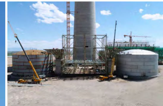
储罐与换热平台施工
